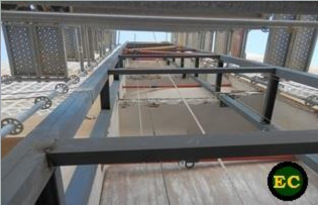
CERRAMIENTO MIXTO, ACRISTALADO Y OBRA
